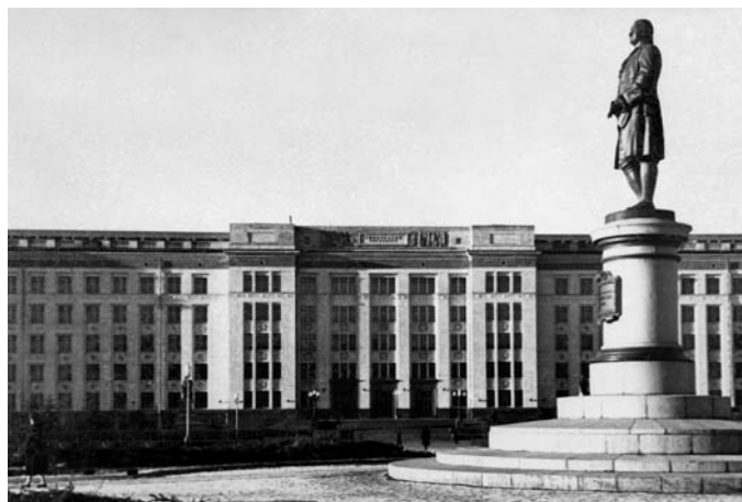
Здание на Ленинских Горах
